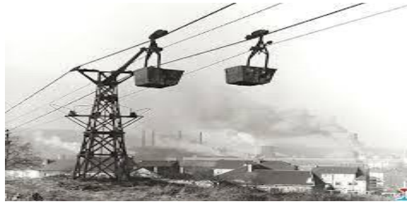
Figure II.7 : Convoyeur à câble [13]
