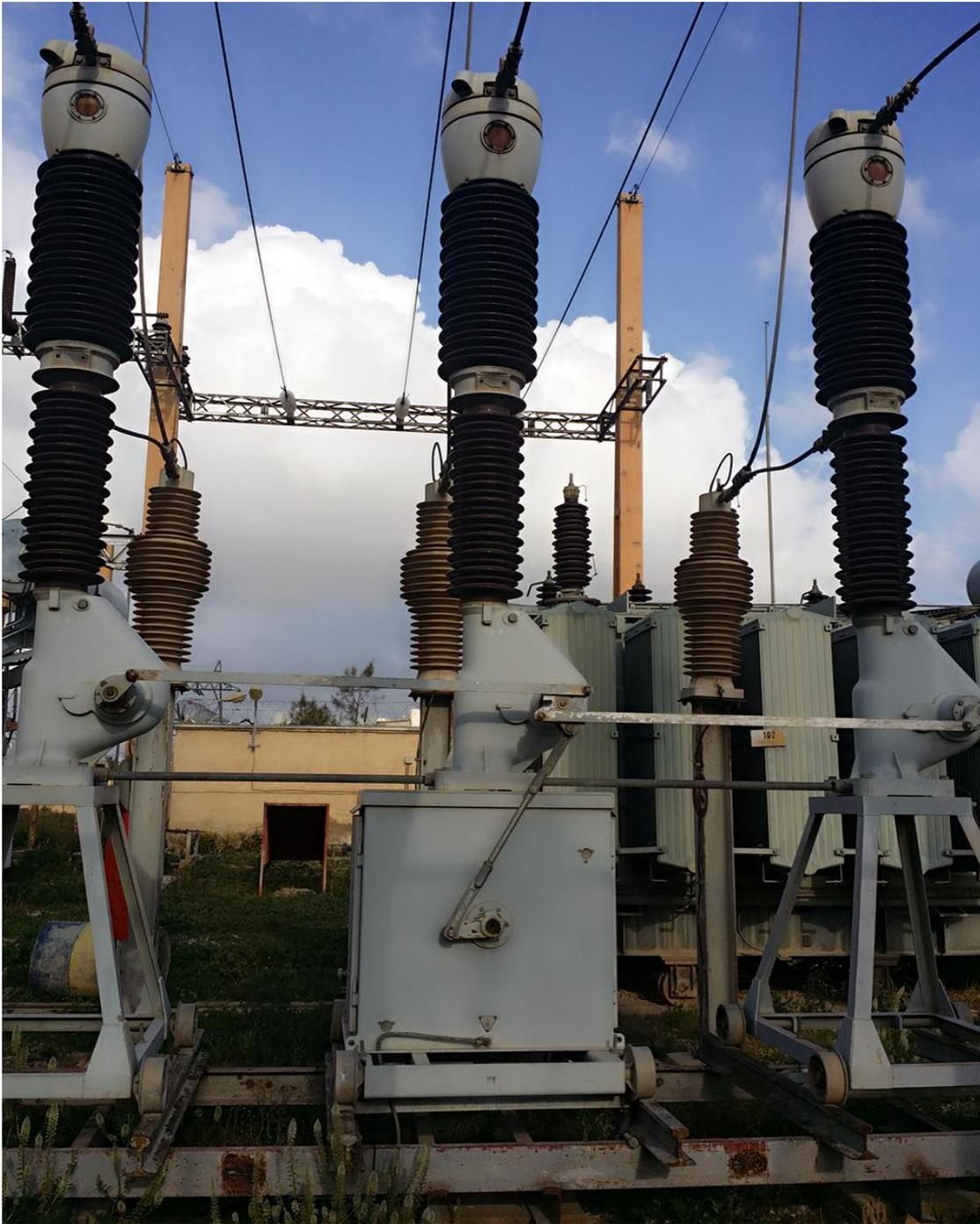
**Figure V.11.** Disjoncteur à l'extinction d'arc à huile [53]
