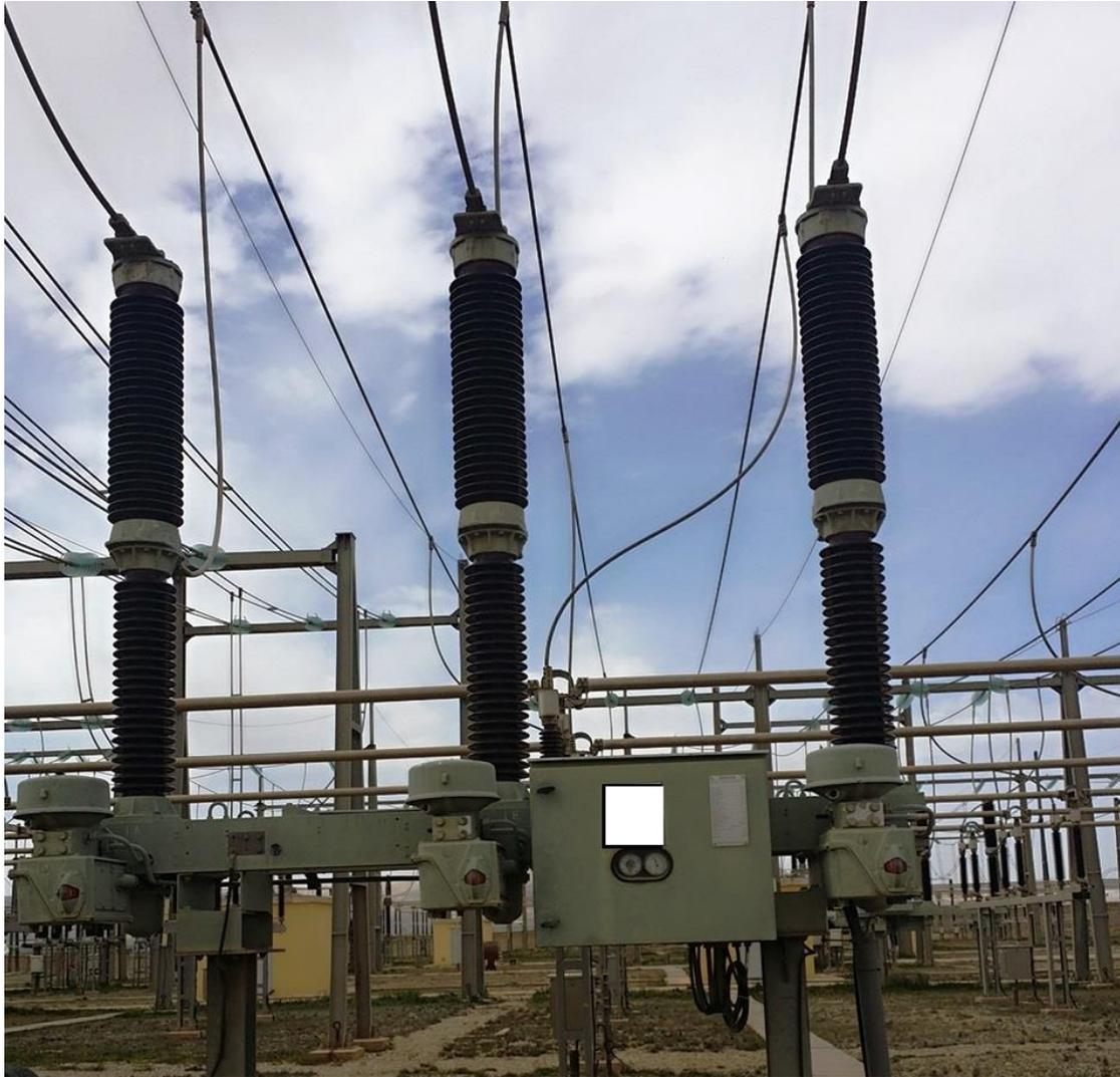
**Figure V.4.** Disjoncteur a l'extinction d'arc avec gaz SF<sub>6</sub>. [51]
