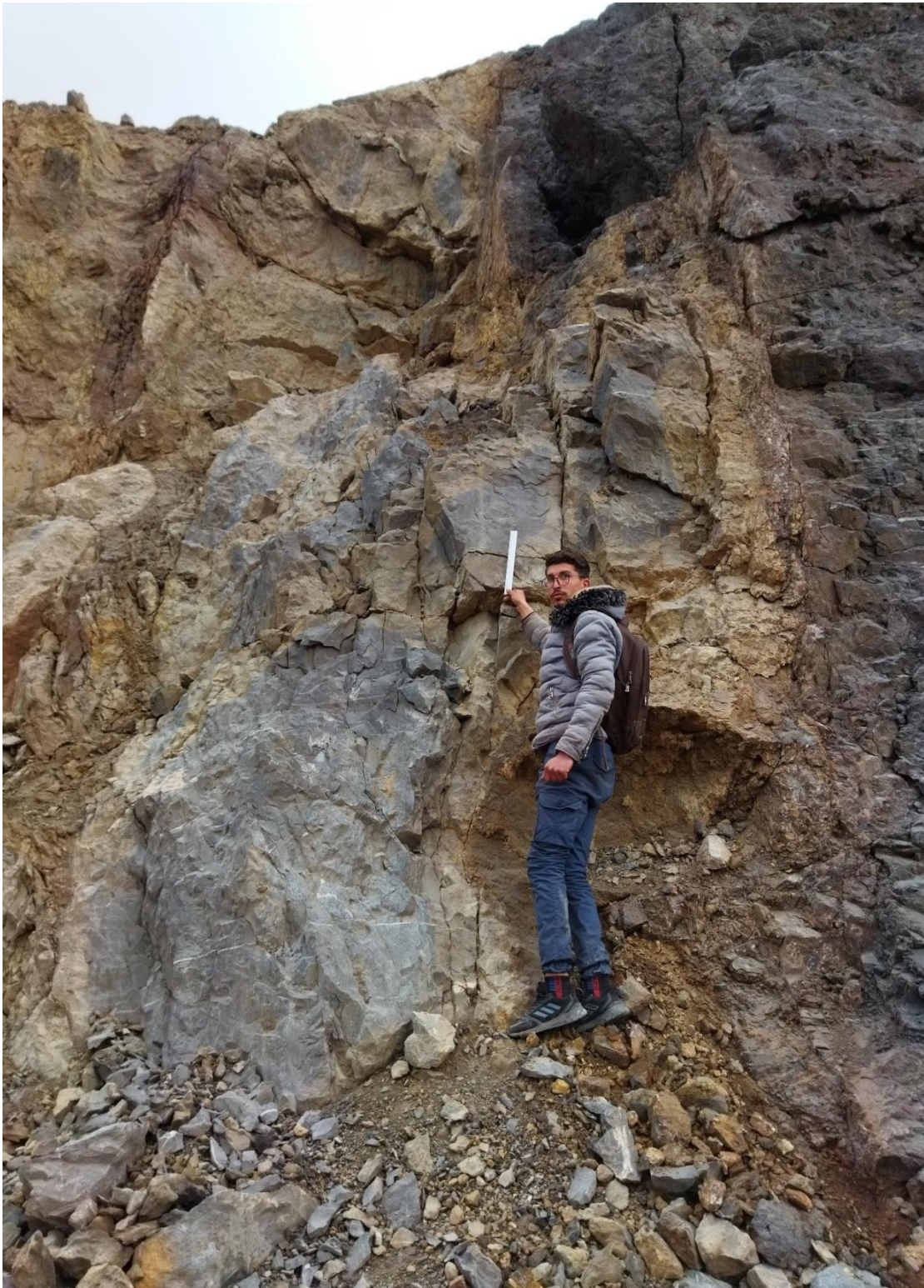
Figure III.2 Vue d'ensemble du front, faisant apparaître 3 systèmes de fissures.
