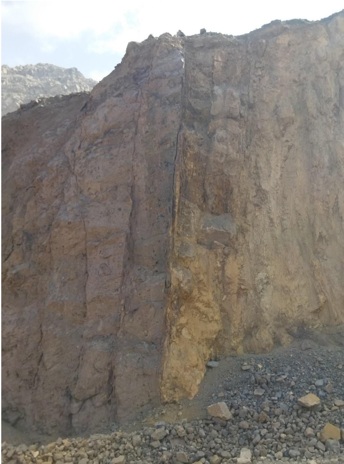
Figure III.1 Inclinaison sub-verticale du principal système de fissuration.
