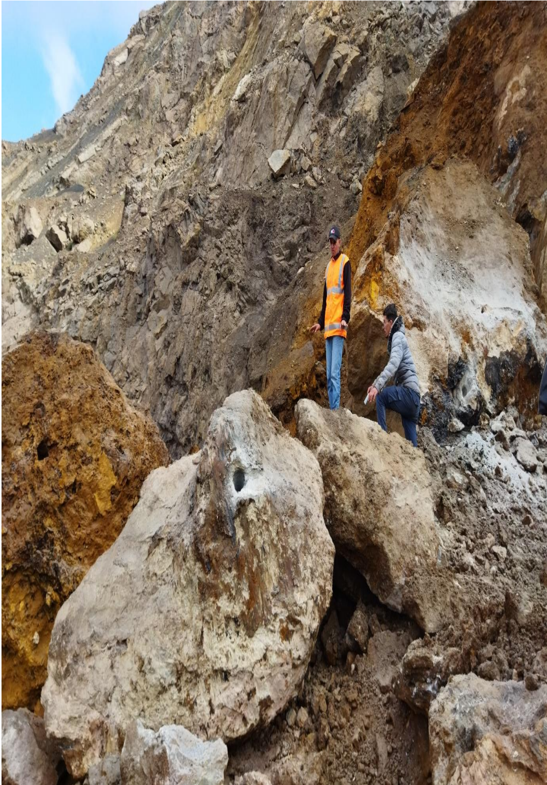
Figure III.5 Débitage des blocs hors-gabarits par foration d'un trou unique.
