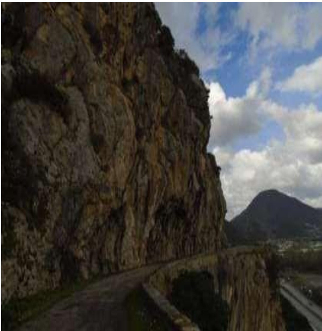
Figure III.9 Exemple de discontinuités dans un massif rocheux (Aokas - Bejaia-, 2015).
