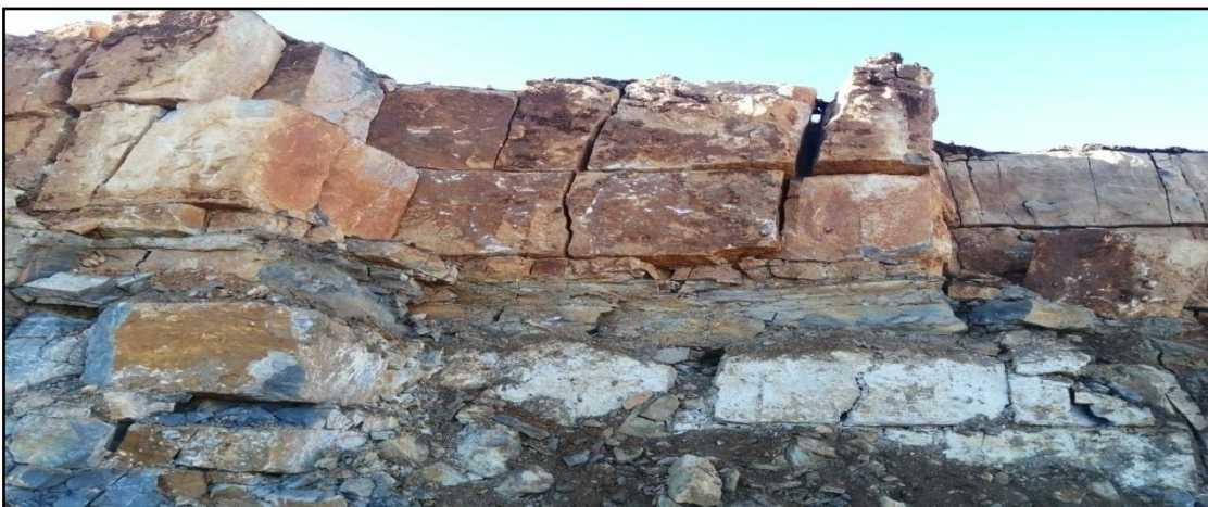
Figure V.5. L'irrégularité des fronts de taille et blocs instables
