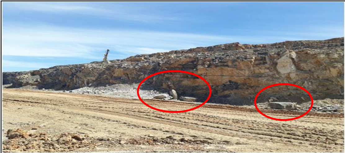
Figure V.3. Chute des blocs sur pied de gradin
