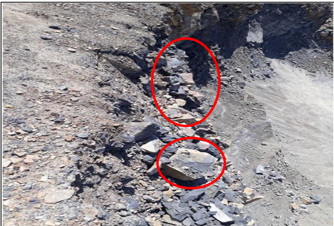
Figure V.10. Chute des blocs de front
