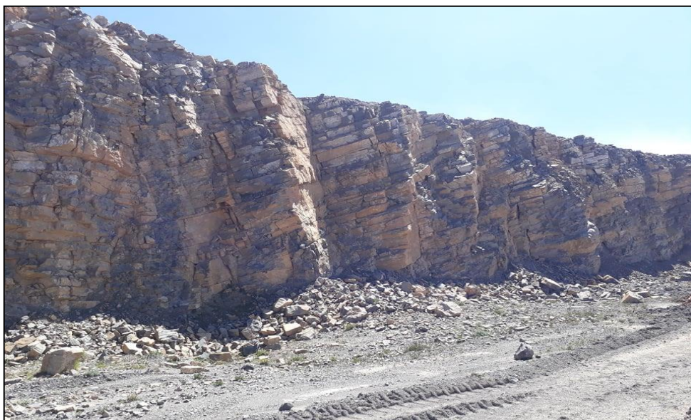
Figure V.2. Irrégularité de parois du front
