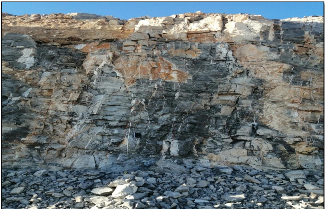
Figure V.12. Front de taille après le tir
