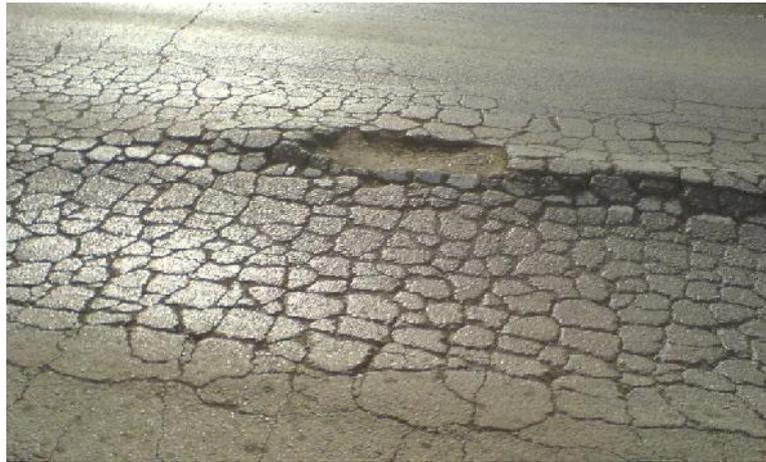
Figure 5.2 État de la chaussée dégradée avant renouvellement
