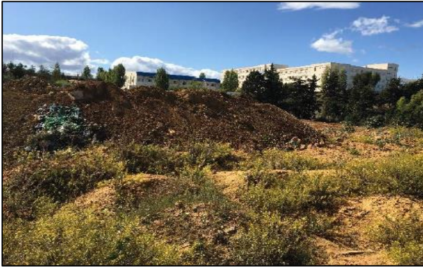
Figure II.29. Dépôt d'un remblai en haut de la pente. [30]
