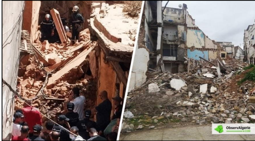
Figure I.11. Effondrement de Casbah (5juin 2020). [20]
