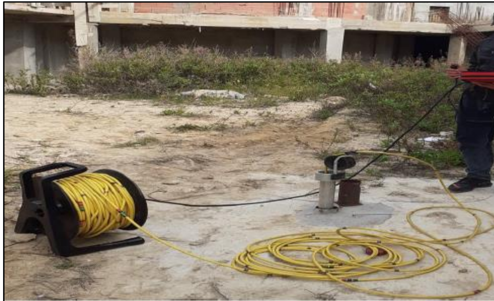
Figure II.20. Mesure à l'inclinomètre au niveau du site d'étude.
