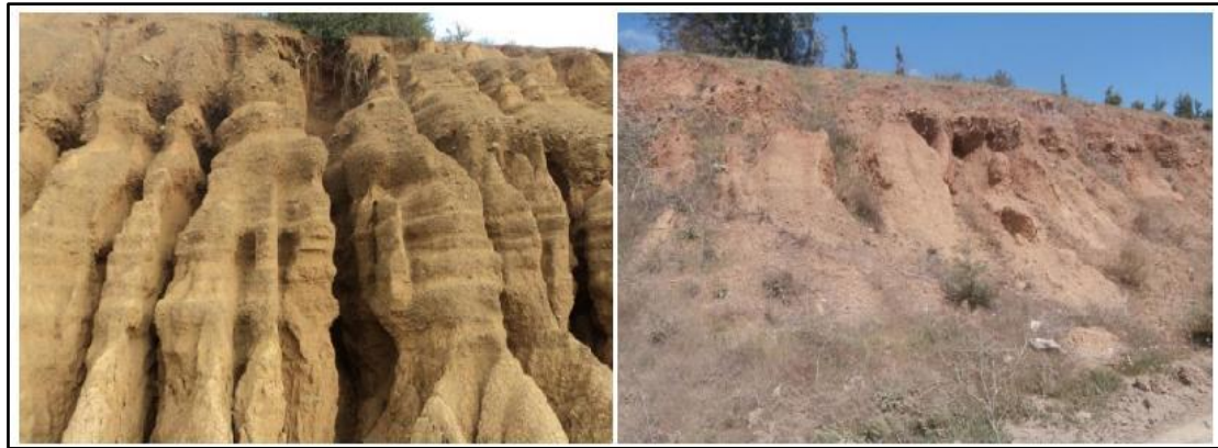
Figure I.17. Exemple de talus de déblai dans des sols de la matrice meuble érodés – CW Boukerdane TIPAZA. [24]
