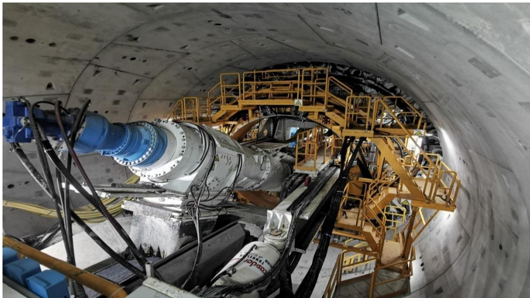
Figure III.7. Le tunnelier Kahina en mode opérationnel.
