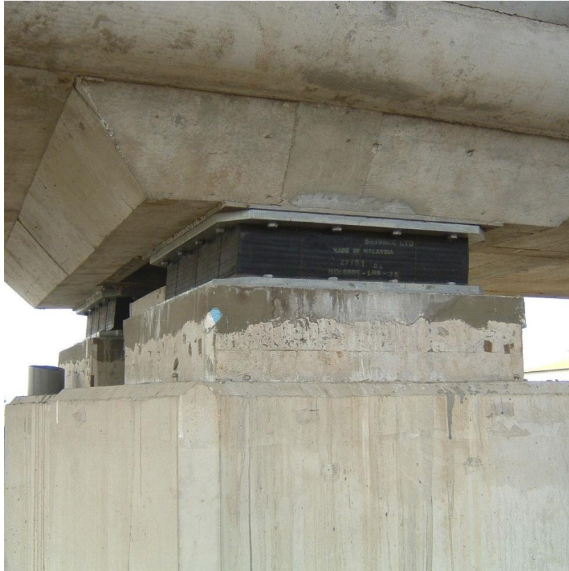
Figure 13. Appareil d'appui en élastomère fretté. [8]
