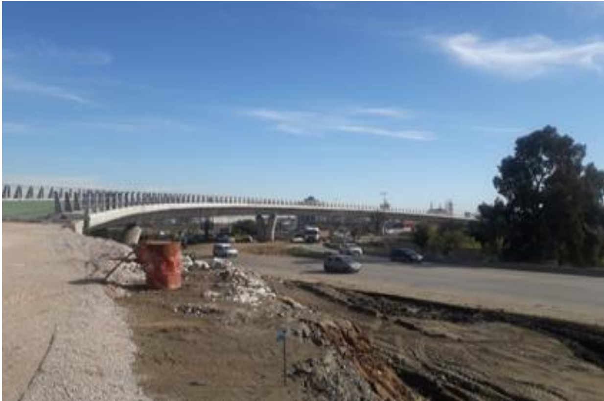
Figure 29. Photo du viaduc X (mars 2020).
