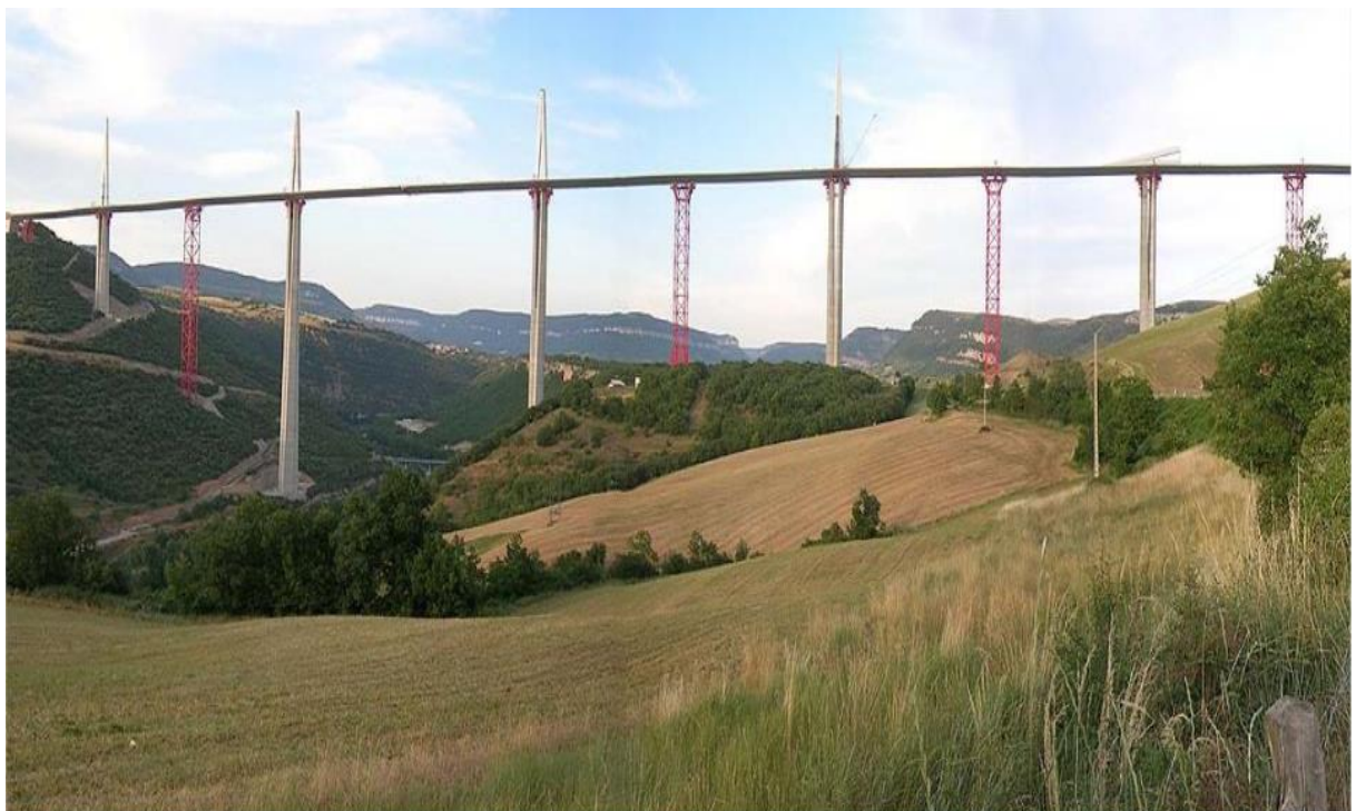
Figure 1. Viaduc de Millau. [2]
