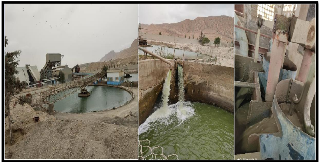
Fig.17 : Système de traitement des eaux de lavage de phosphate
