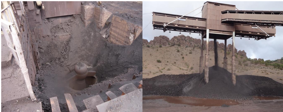
Figure 5: Entrée et sortie du minerai dans le concasseur
