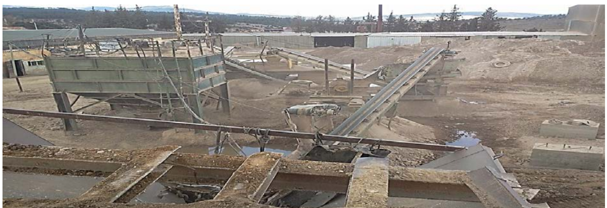
Figure II.03 : Vue générale de la station du traitement actuel de Ain Mimoun [08]
