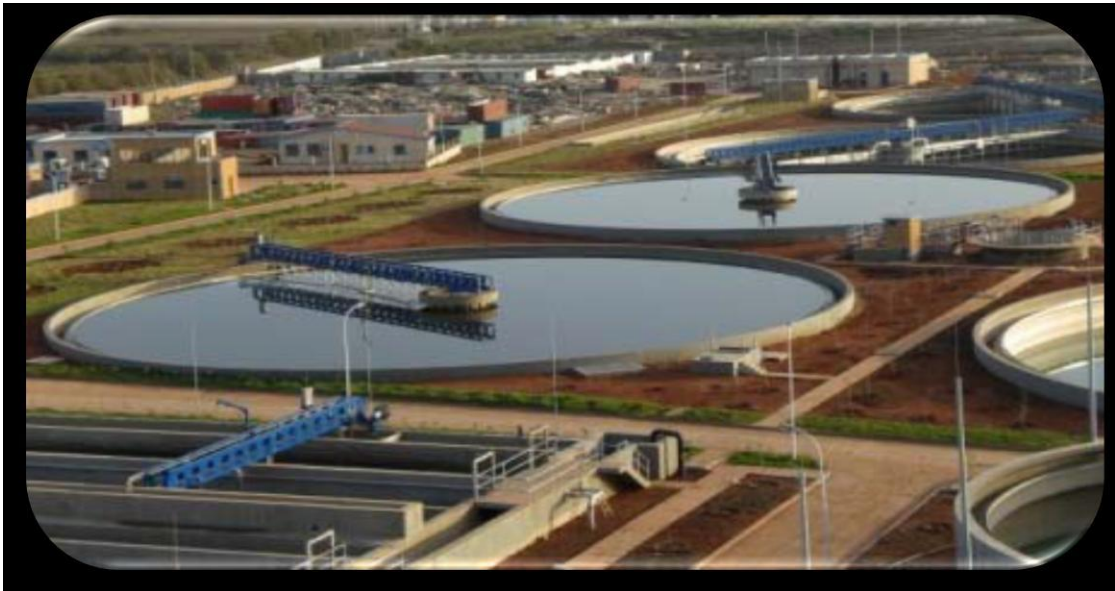
Figure II.5. Décanteur primaire
