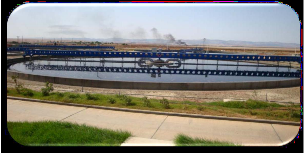
Figure II.7. Décantation secondaire
