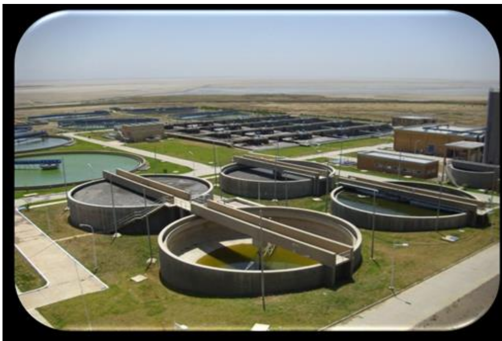
Figure II.8. Épaississement gravitaire
