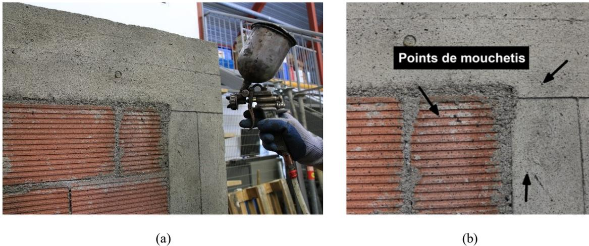
**Fig. 62** Projection de mouchetis (a) et points de mouchetis réalisés sur la face frontale (b)
