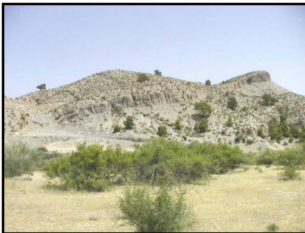
Figure I.5: Vue de l'appui rive droite (depuis l'amont) (ANB, 2005).
