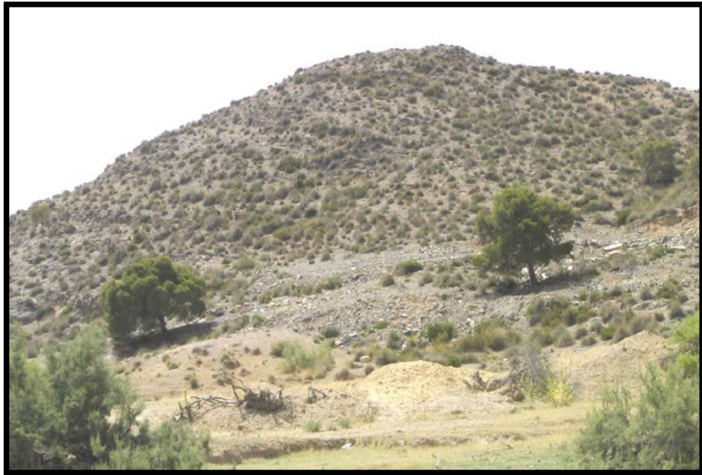
Figure I.6: Vue de l'appui rive droite (depuis l'aval). (ANB, 2005).
