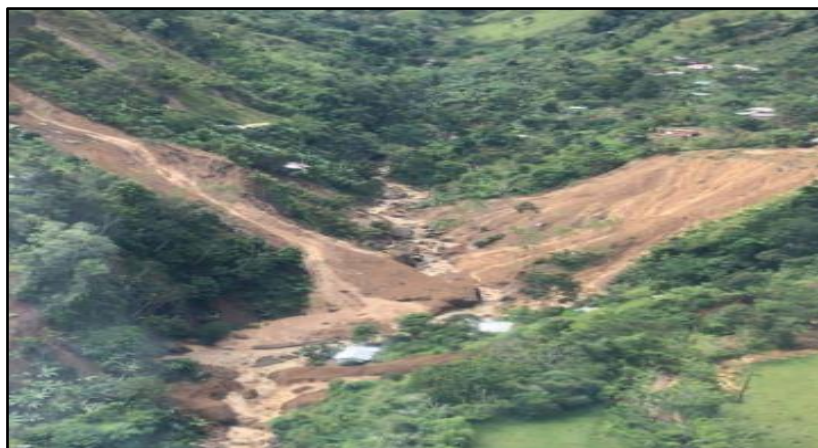
Figure I.13. Glissement terrains en Colombie (10 Novembre 2020). [21]
