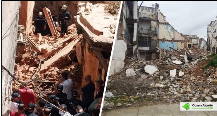
Figure I.11. Effondrement de Casbah (5 juin 2020). [20]
