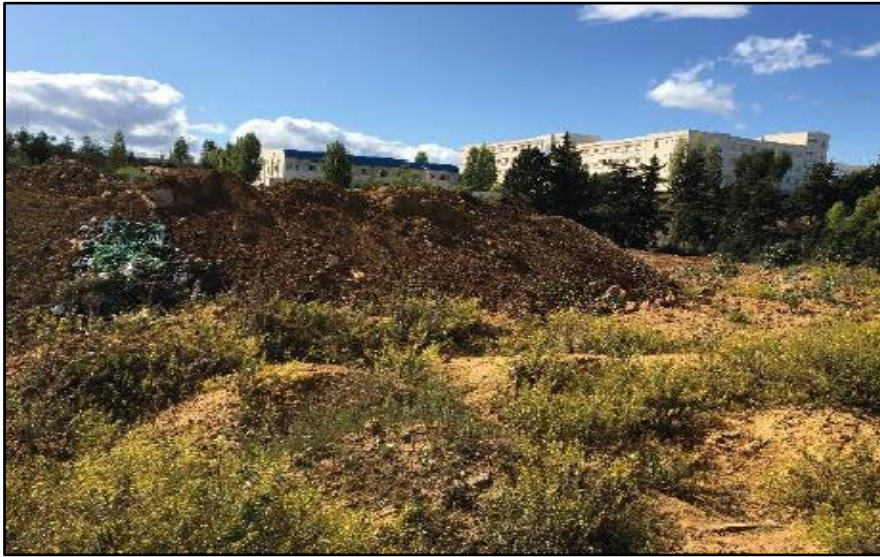
Figure II.29. Dépôt d'un remblai en haut de la pente. [28]
