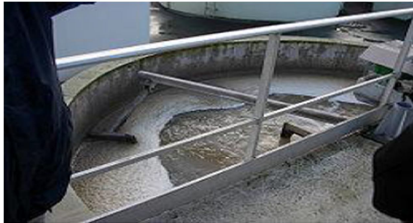
Figure12: Le déshuilage par écumage des graisses ( Anonyme, 2006 ).
