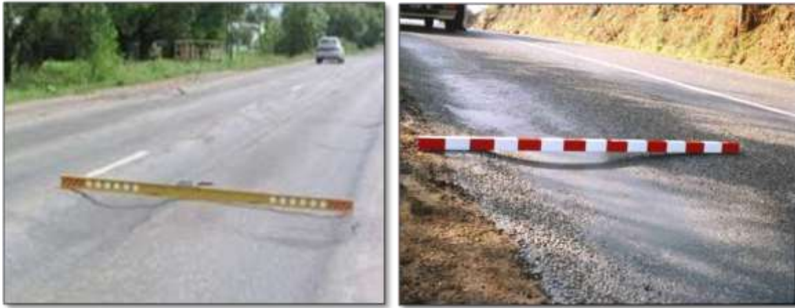
Fig. II.1. Orniépage de la chaussée [19, 20]
