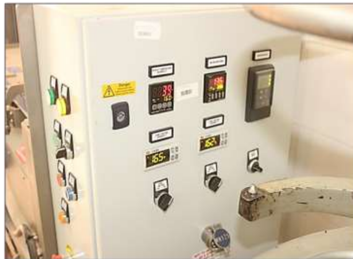
Fig. V.18. Malaxeur à température 165 °C
