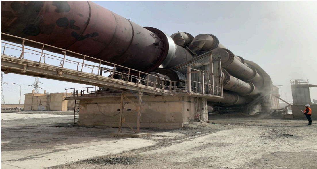
Figure14. Four rotatif dans une cimenterie de la région d'Elma labiod Tébessa.
