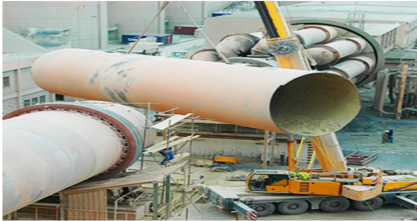
Figure 17. virole de four cimenterie.
