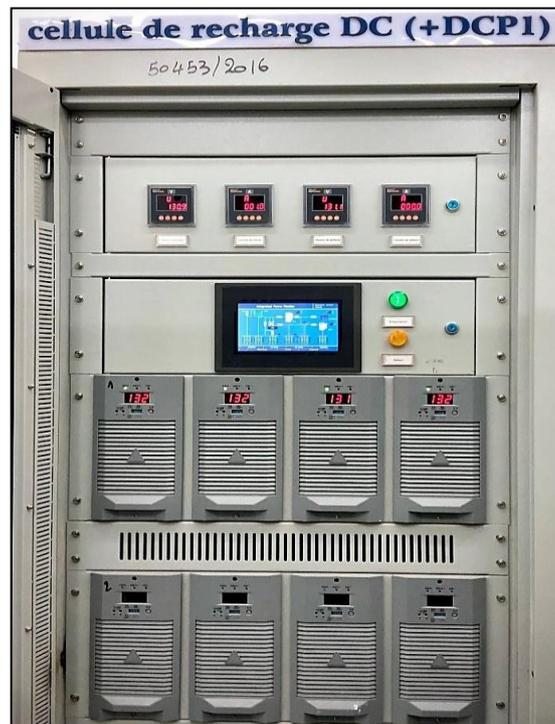
Figure 51. Redresseur-Chargeur.
