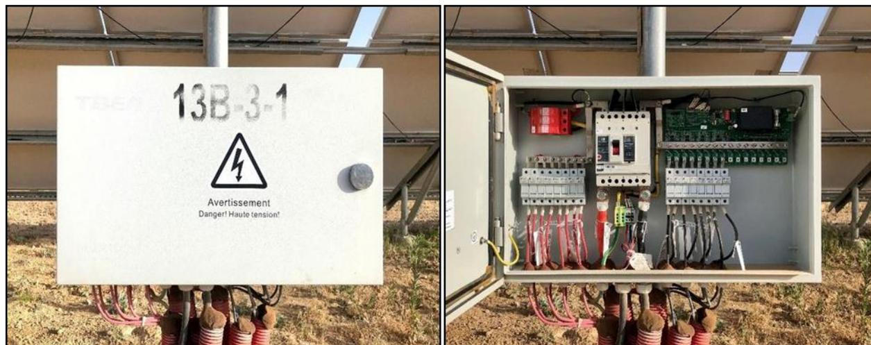
Figure 38. Boite de raccordement Niv1.
