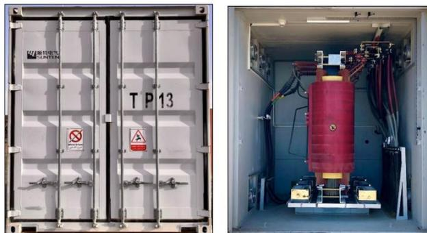
Figure 41. Transformateur SUNTEN utilisé dans la centrale OKP.
