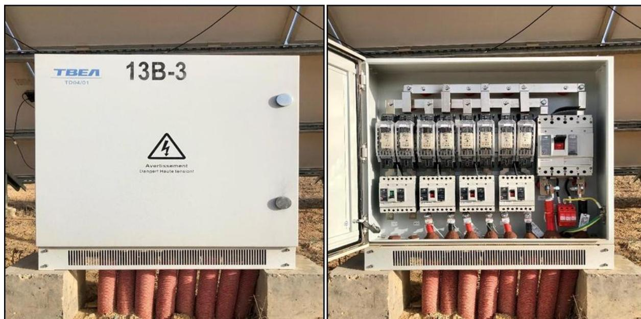
Figure 39. Boite de raccordement Niv2.
