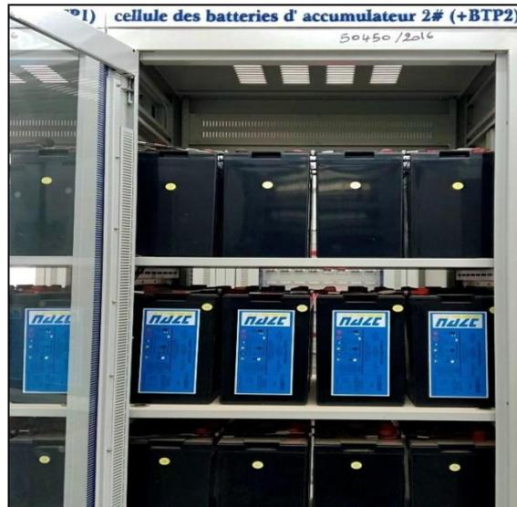
Figure 50. Batteries de secours.
