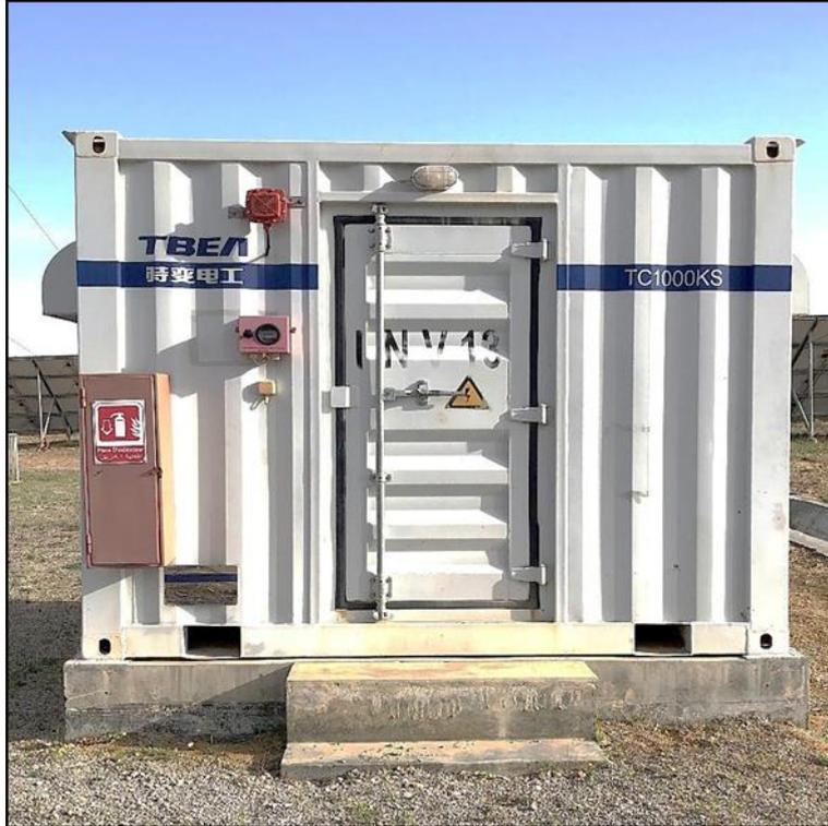
Figure 40. Onduleur TBEA utilisé dans la centrale OKP.
