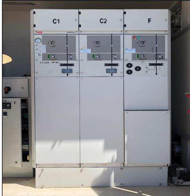
**Figure 43. Cellule de boucle.**
