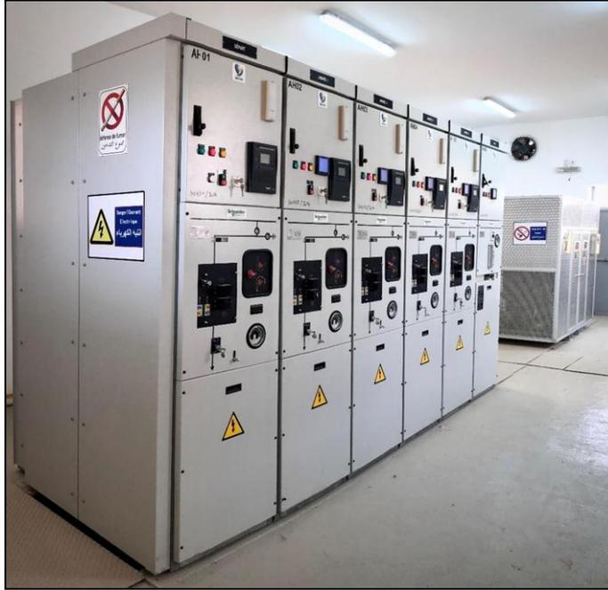
Figure 44. Cellules du poste d'évacuation
