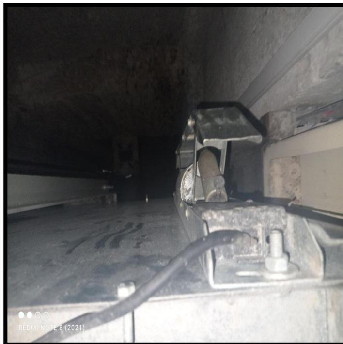
Figure IV.26. La came (dispositif de retirer de la serrure).
