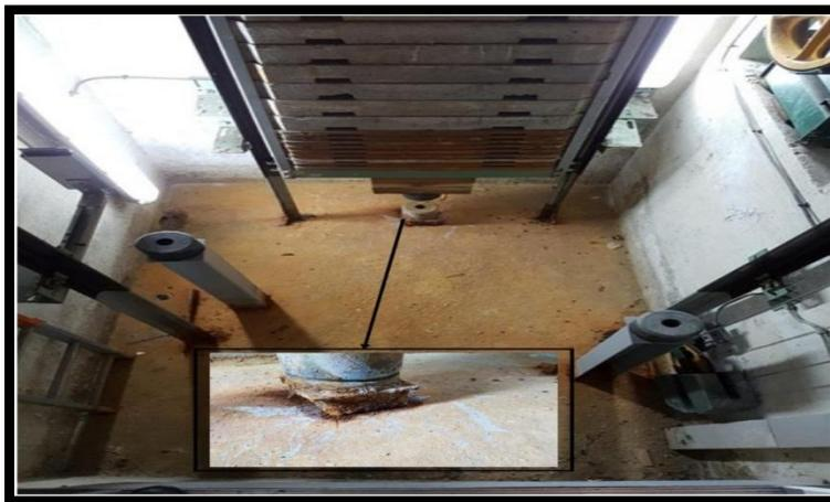
**Figure III.2. Fond de cuvette. [19]**
