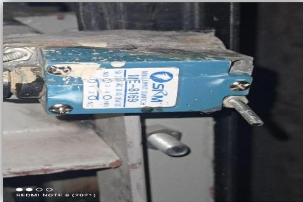
Figure IV.23. Capteur de fin de course haute
