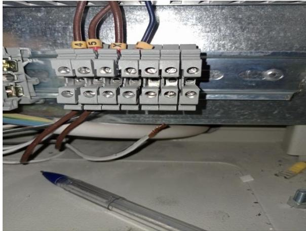
**Figure IV.19.** Borniers des câbles.
