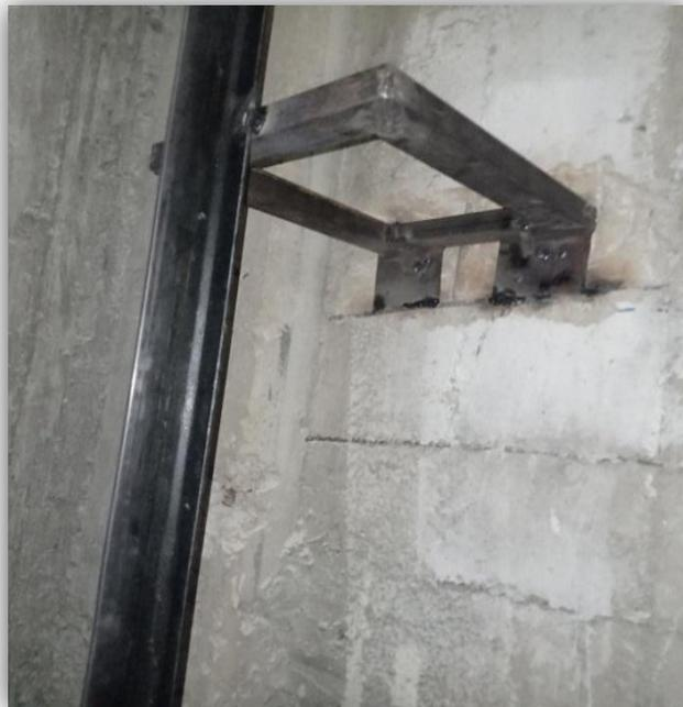
**Figure IV.28.2.** Support de fixation« Rail ».
