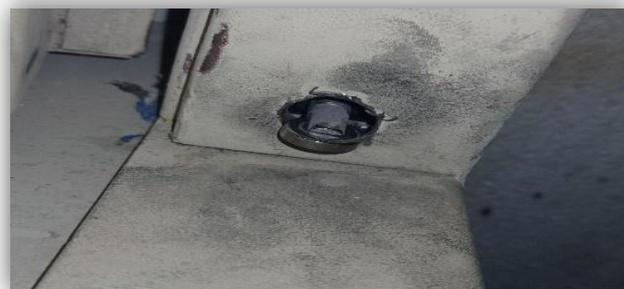
Figure IV.37. Capteur de fermeture de porte.
