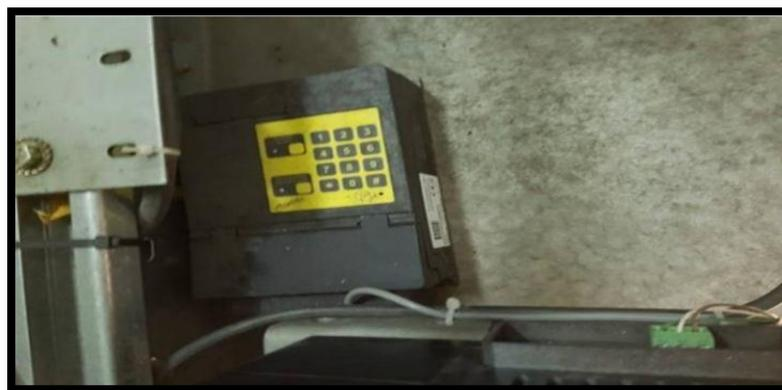
**Figure III.5.** Système de demande de secours. [4]
