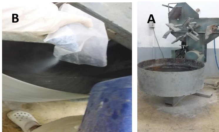
Figure : II.30 malaxeur électrique(A) ; mélangé le béton(B)
