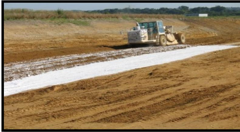
**Figure I.9 :** Traitement à la chaux. [5]
