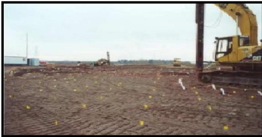
**Figure I.30:** Chantier de réalisation des drains verticaux.[8]
