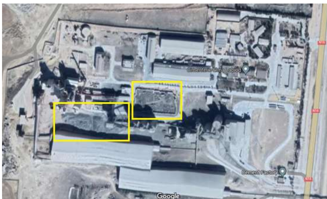
Figure II.31. Stockage du clinker incuit et mal cuit à l'air libre, cimenterie d'El Ma Labiod – Tébessa.
