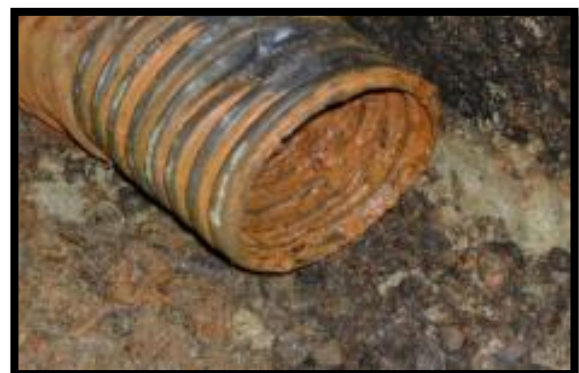
Figure 51 : a : Drains subhorizontaux. b : Colmatage d'un drain
