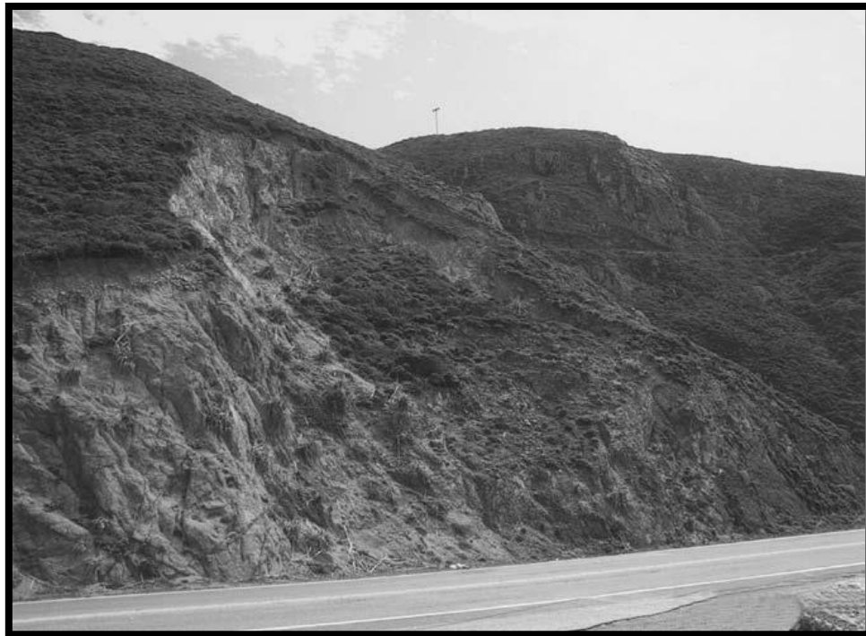
Figure 71 : « Rupture circulaire dans une roche granitique fortement altérée » (Duncan 2008, autoroute en Californie).
