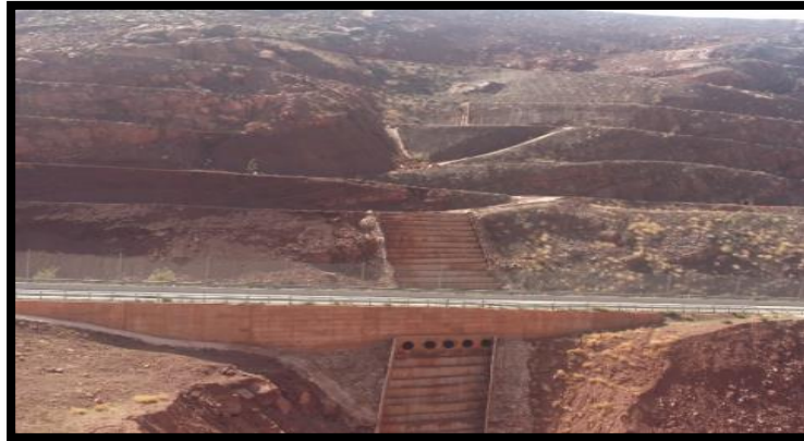
Figure 48 : Évacuations des eaux superficielles dans le déblai (Ahmari Ahmed 2021)
