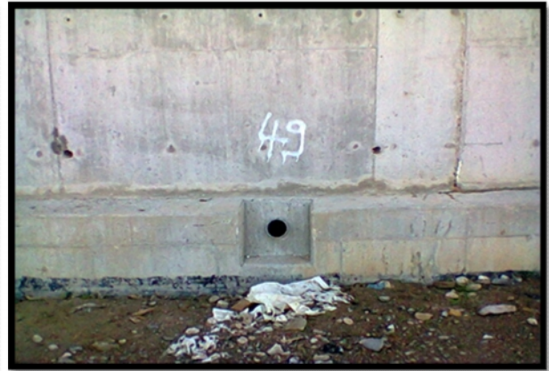
Figure 3 .4 Le forage après la réalisation
