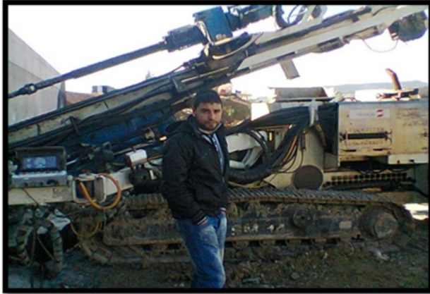
Figure 3 .3 Réalisation d'un Forage avec une grue
