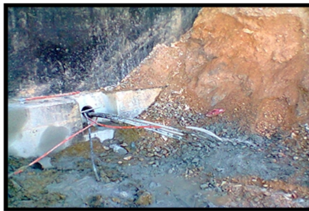
Figure 3 .5 Nettoyage du forage
