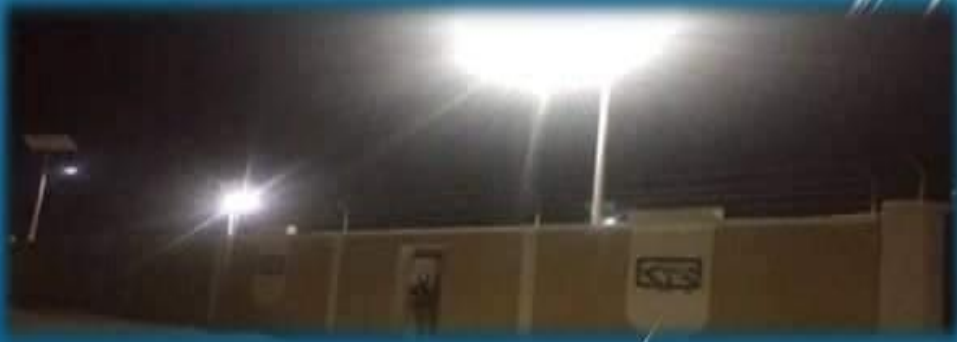
Panneaux solaires à LED
