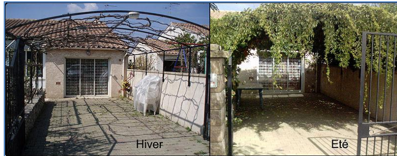
Photo n° 37: La treille laisse passer la lumière en hiver et assure de l'ombre en été. Source: Site Web
