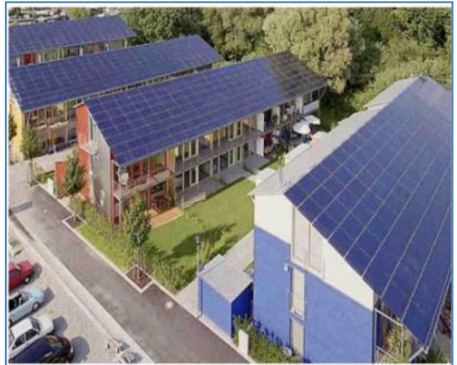
Photo n° 09: Exemple de bâtiment à énergie positive à Freiburg en Allemagne, Source : Site Web
