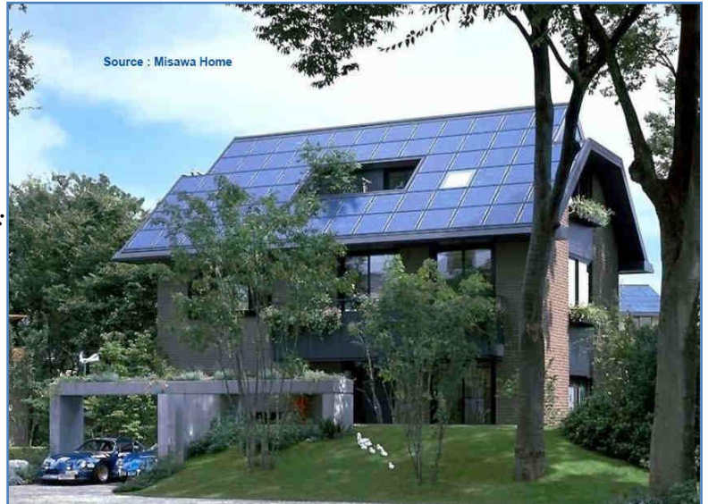
Photo n° 11: Maison "zero energy", Source : Misawa homes dans Daniel Quenard, Vers des bâtiments à énergie positive (CSTB Grenoble, Département Enveloppes et Revêtements, présentation du 20/10/2005).
