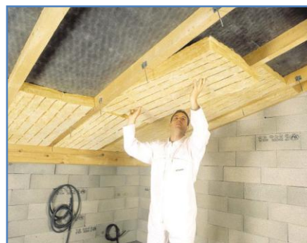
Photo n° 26: Mise en place de panneaux de laine de verre. Source : Guide de l'éco-construction, Agence régionale de l'environnement en Lorraine. [ADEME]. p:19.
