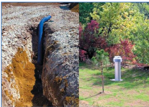
Photo n° 54 : Principes du puits canadien. Source: Une maison passive à Eraville, Charente, [France, Octobre 2012.]
