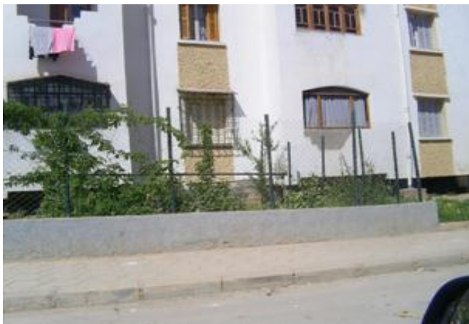
Figure N°38 : Façades d'un immeuble faisant parti des 50 logements sociaux locatifs À l'UV 01 – Programme 2000. Constantine- Nouvelle Ville Ali Mendjeli.
