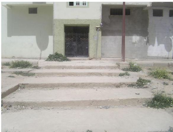
Figure N°48 : L'accès au bâtiment. 35 logements sociaux participatifs à l'UV 05 Constantine-Nouvelle Ville Ali Mendjeli.
