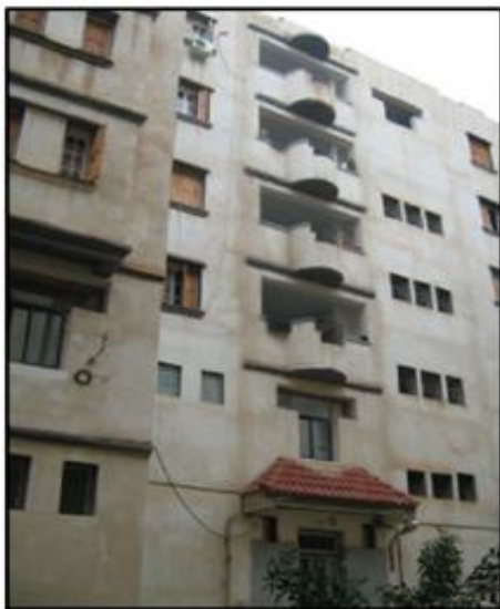
Figure N°13: Vue sur la façade principale du bloc B1 (prise du point A)
