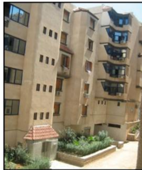
Figure N°14 : Vue sur la façade principale du bloc B2 (prise du point B)
