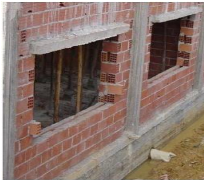
Figure III.8 : composition des murs extérieurs, source BET :Bouteraa Adel
