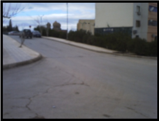
Figure N°32 : Accessibilité de site
