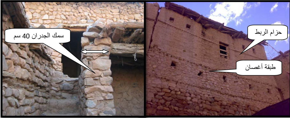
الصورة رقم (27): تبين سمك الجدران و حزام الربط
