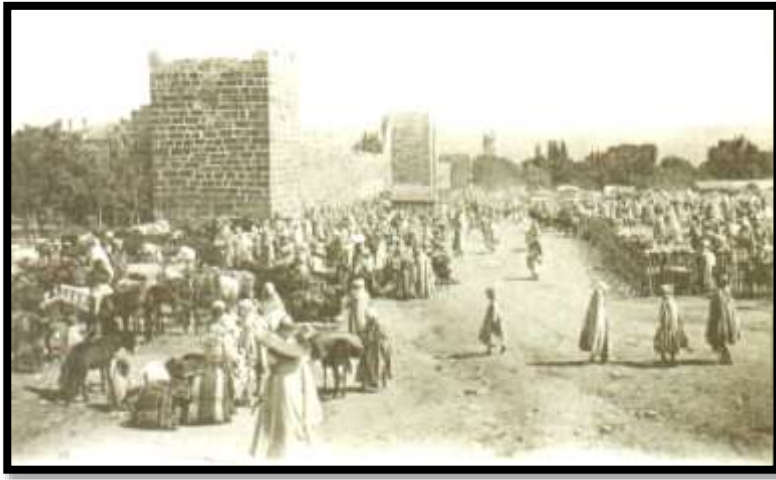
Figure 14 : Vue extérieur sur la muraille byzantine à l'époque
