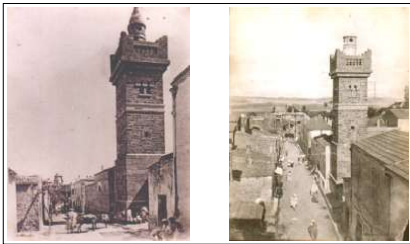
Figure 23 : Mosquée El Atiq à l'époque
