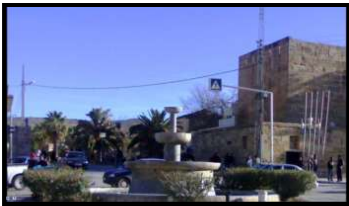
Figure 21: Porte de Constantine après sa destruction
