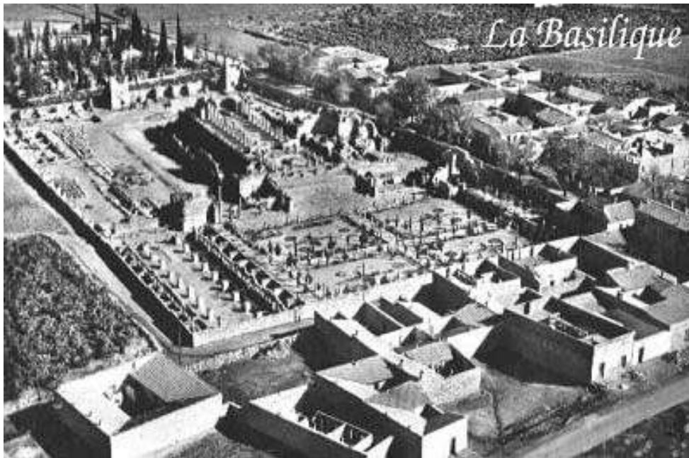
Figure 9 :Vue aérienne de la basilique (pendant les années cinquante)*
