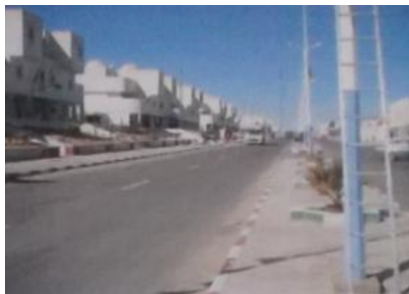
Figure 28 Photo, logements collectifs à oued Souf, source : Filali, M. 2005.
