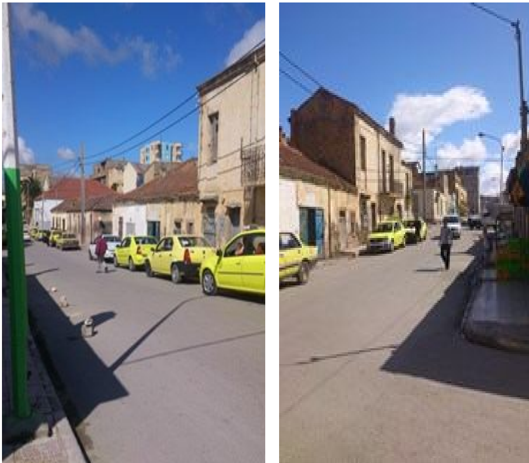
Figure n° 05 : Un cadre bâti frappé par la dégradation, une image plus en plus courante au centre-ville de Souk-Ahras
