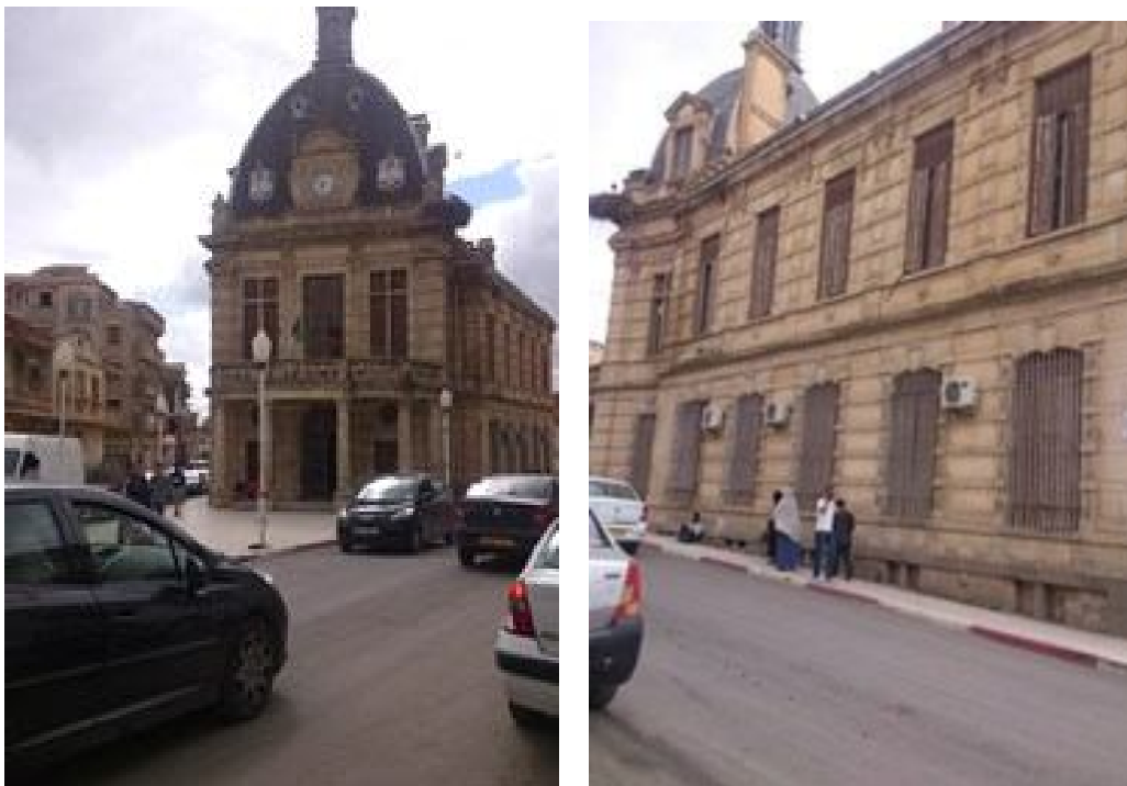
Figure n°11 : quelques équipements reflétant la ville culturelle au centre
