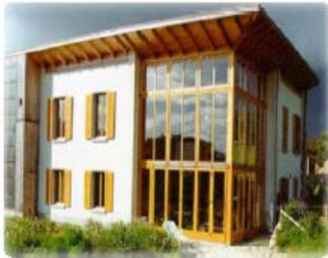
Figure 35: Avant toit protégeant des rayonnements du soleil (Source A. Lièbard A. De Herde).
