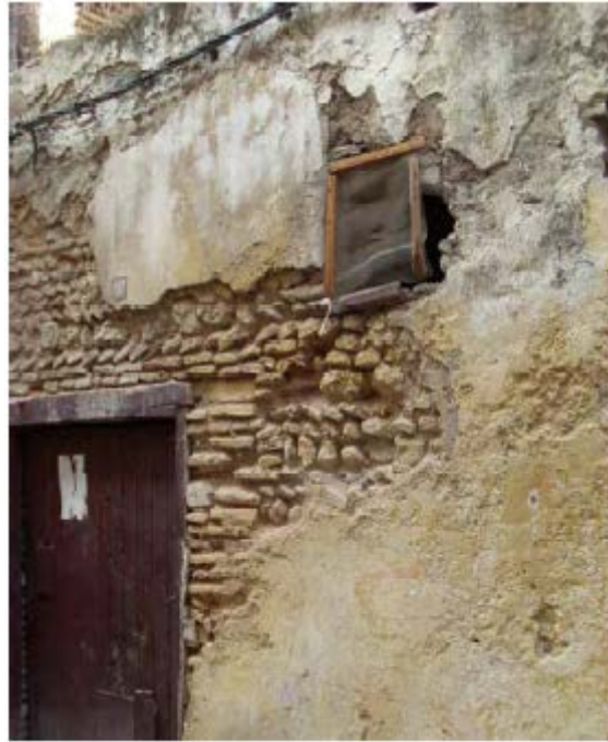
Figure 8 Détail d'un mur à moellons, Source Atif.S
