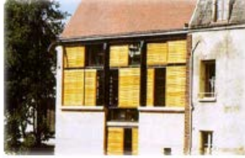
Figure 34: Volet coulissant permettant de tamiser la lumière (Source A. Lièbard A. De Herde)
