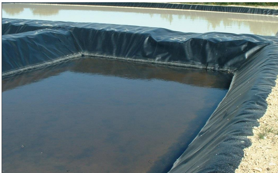
Photo 46: bassin de drainage lixiviat dans CET Tébessa
