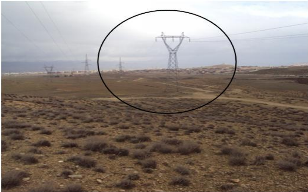
Photo 05 : ligne de transport de l'énergie électrique de haute tension
