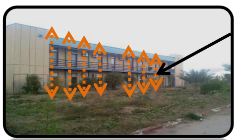
Façade sud (hébergement)
