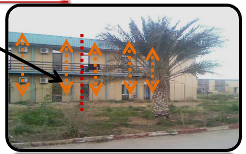
Façade sud (hébergement)
