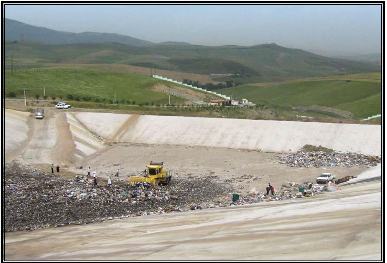
Photo 3 : Vue du 1er casier d'enfouissement d'une capacité de stockage de 360 000 M3 mis en service. Source : (Auteur, CET, Mars 2016)
