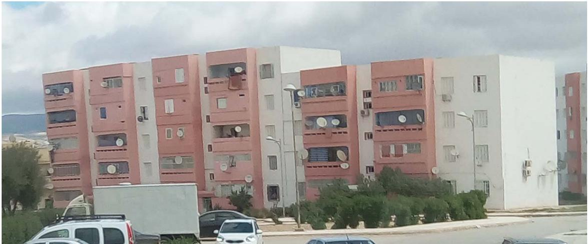
Fig. 40 : Façade modifiée avec balcons supprimés, et barreaudage de types différents : Cité 414 logements.
