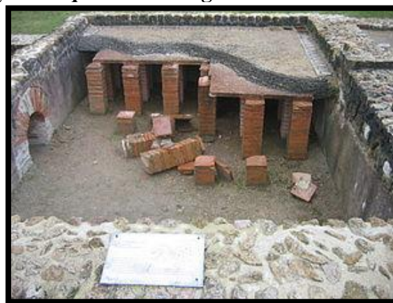
Figure 37 : Coupe du système d'hypocauste des thermes d'une villa de vieux-la-Romaine, Calvados, France
