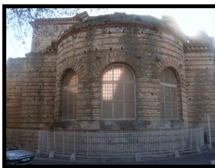
Figure 22 : Baies du caldarium des thermes de Constantin à Arles.
