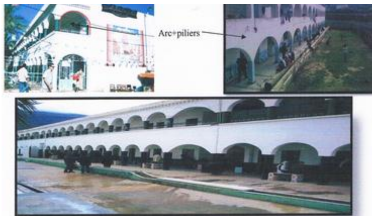
Figure 53 : les différentes façades de la station source l'auteur
