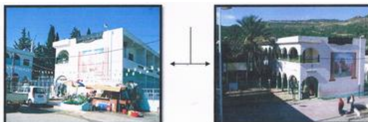
Figure 50 : les accès de la station thermale source l'auteur
