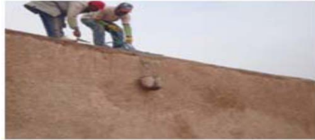
Photo29.30.31 : couronnement et protection du mur
