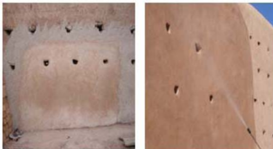
Photo24.25 : mortier à base de chaux
