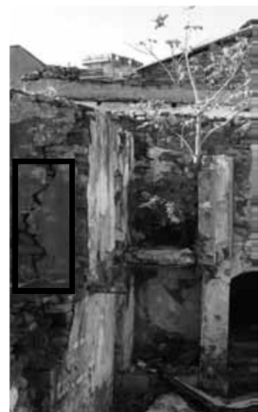
Photo34 : poussée transmise par la couverture
