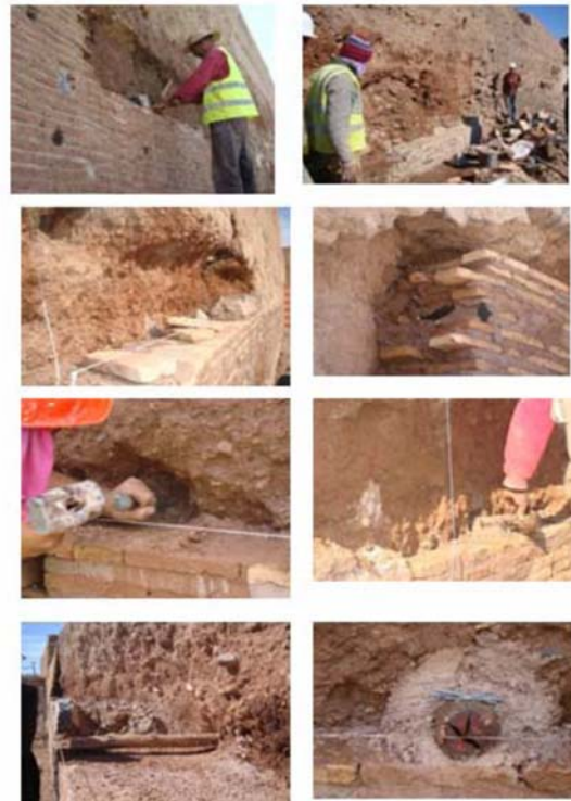
Photo 23. : Des rondins en bois cloutés seront ancrés dans le mur
