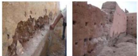
photo 19,20 : démolition des parties non stables
