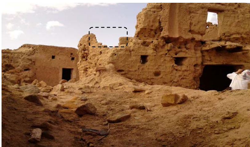
Photo 40: effet du vent sur les toits
