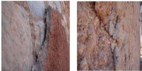
Photo 21.22 : mortier en ciment
