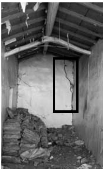
Photo32 : l'affaissement des fondations (angle)
