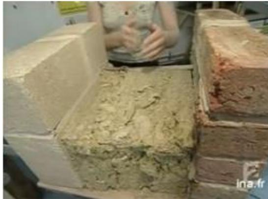
Figure 21 : mur en trois épaisseurs; béton + brique pleine + 30 cm de laine de roche, Vauban, (Allemagne).
