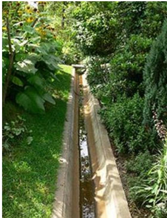
Figure 45:les eaux ruissellement des axes circulants sont collectées et épurées à part, Eva Lanxmeer, (Pays-Bas).
