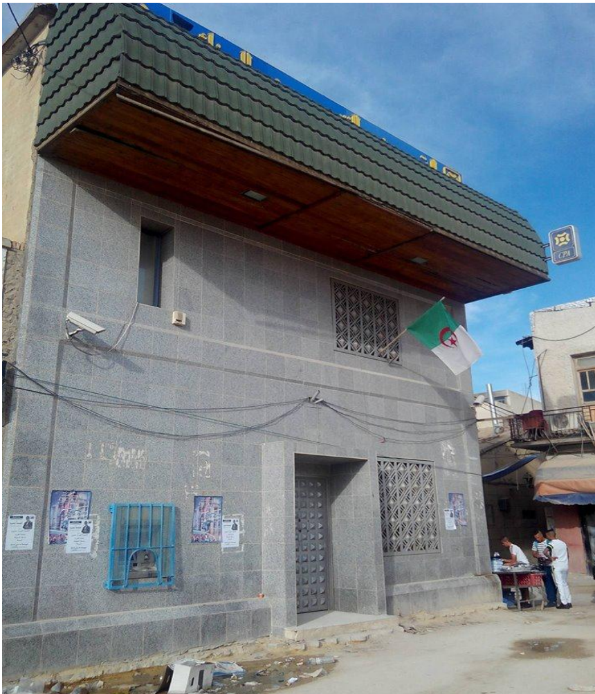
Photo22 :Façade principale de la CPA auteure :krid lidia
