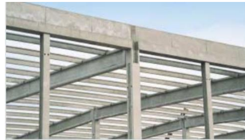
Fig.20: exemple des pannes
