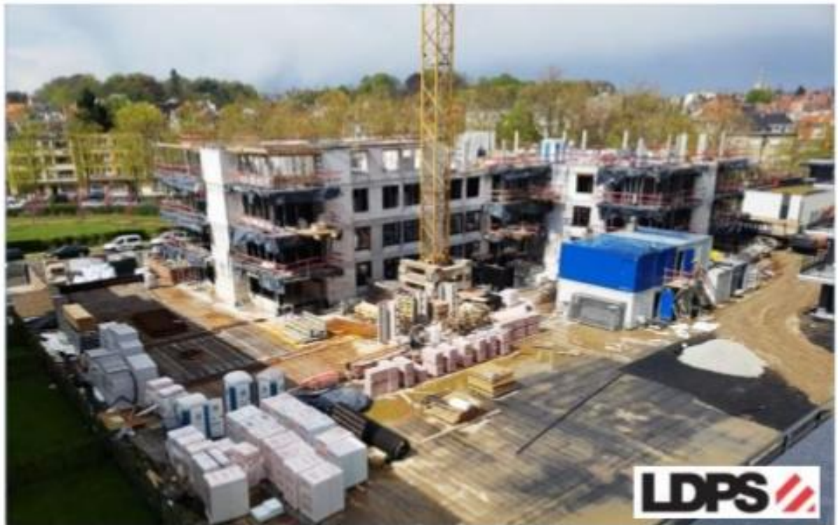
Fig.111: projet en cours de réalisation (3eme étage)
