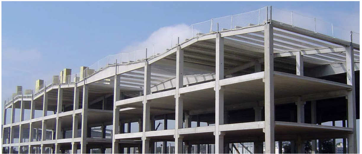
Fig.108: Utilisation des éléments préfabriqués dans la construction industrielle
