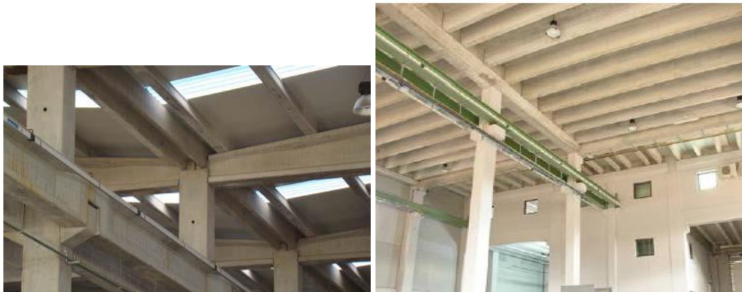
Bâtiment industriel avec dalle double T pour couverture
