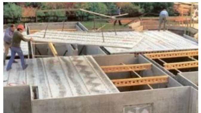
Figure24 : Exemple de plancher à pré-dalles
