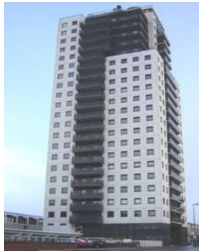
Figure34 : exemple Bâtiments préfabriquées à appartements a 23 étages au Pays-Bas
