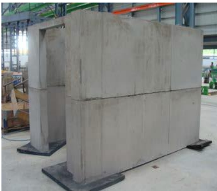
Montage de cage d'ascenseur
