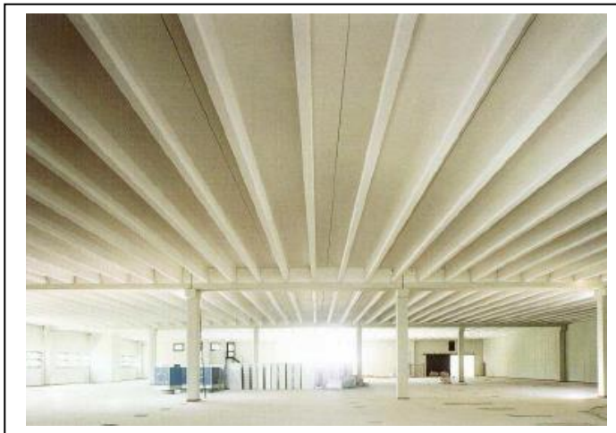
Figure23 : Exemple de plancher nervuré double T
