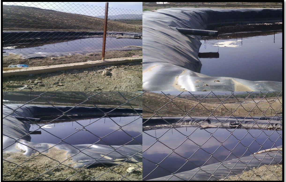
Le drainage de lexiviat des déchets dans des bassins,
