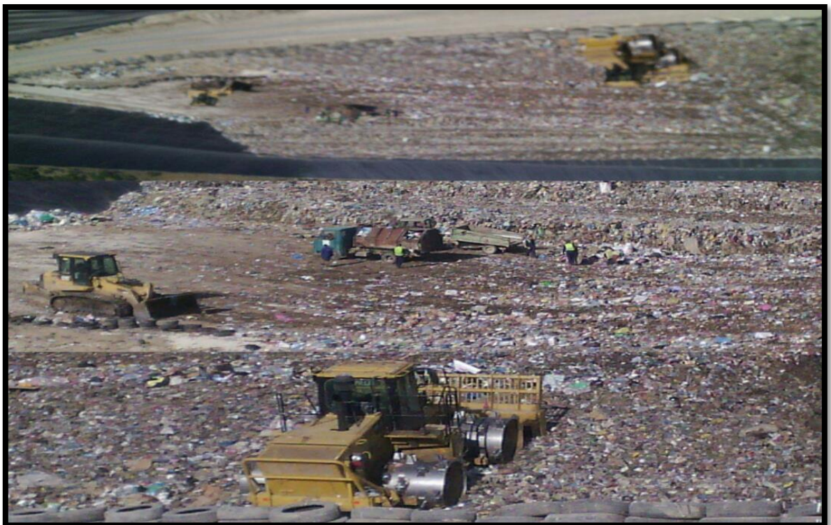
Le compactage au niveau du casier,
