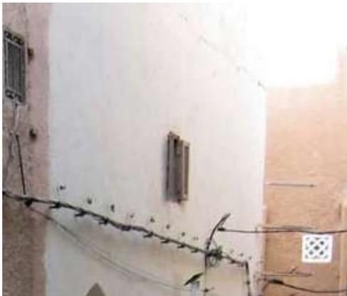
**Les ouvertures de logement, en particulier surplombant la rue directement doivent être vertical et minoritaire également pour réduire les fuites d'air chaud et le vent de sable à l'intérieur de la maison pour préserver l'isolation thermique et**
