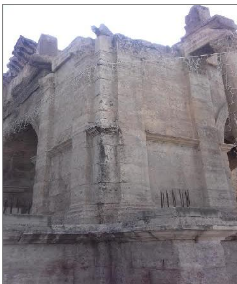
Photo 02 : Colonnes détruites, source : l'auteur
