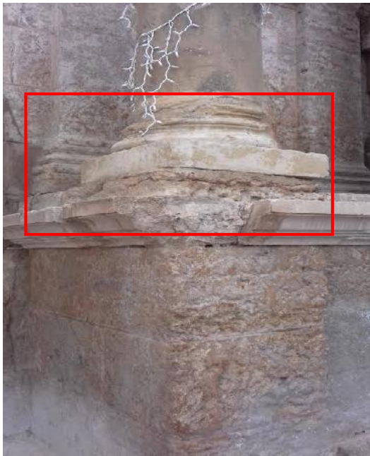
Photo 07 : Dégradation au niveau du piédestal, source : l'auteur.
