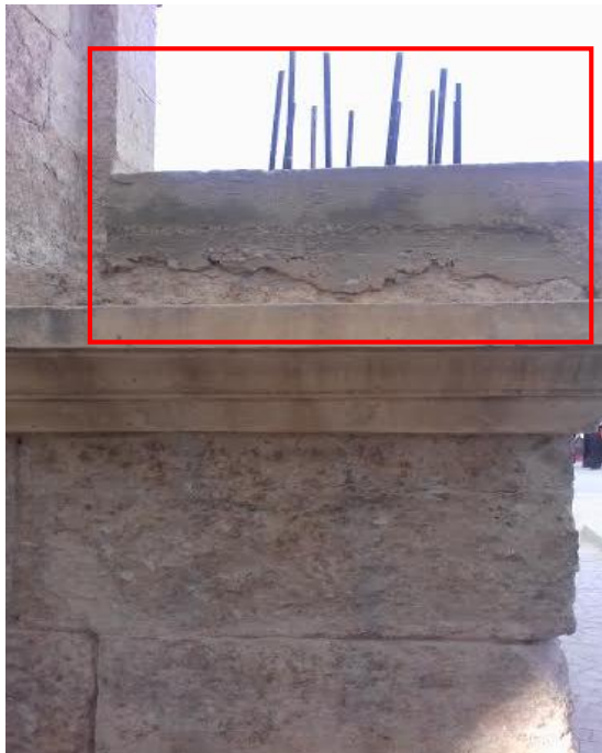
Photo 09 : Reconstruction par des matériaux hétérogène, source : l'auteur.
