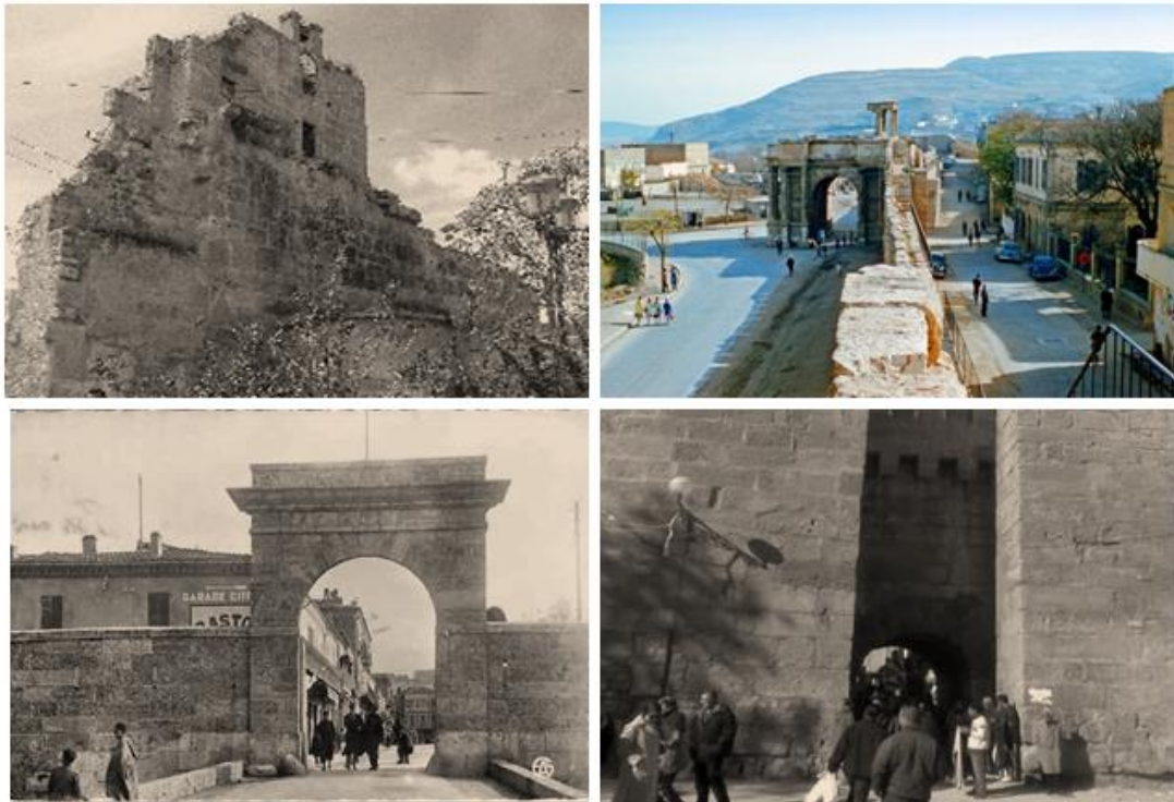
Figure 13: Entrées du noyau central de Tébessa, source : www.flickr.fr (Traité par l'auteur)
