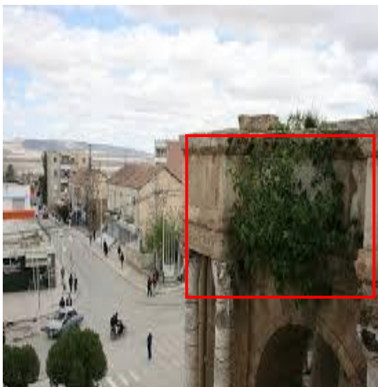
Photo 20 : Apparition des plantes dans la partie supérieure de la porte, source : l'auteur.
