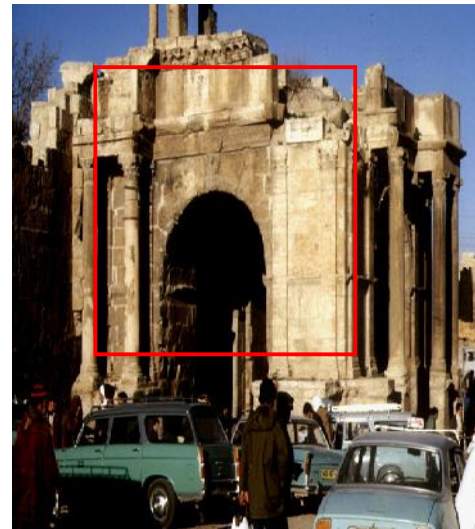
Photo 15 : Taches d'humidité au niveau de l'arc, source : l'auteur.
