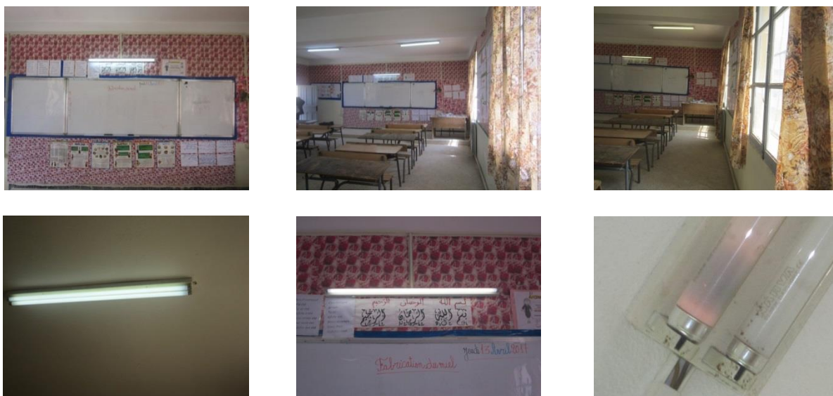
Figure 41 : photos de l'IN-situ salle de classe 01 école Tebib Zina Tébéssa
