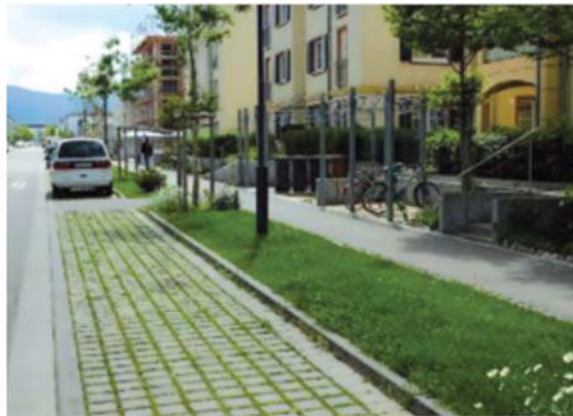
Figure 3.3: Pavés à joints plantés, Source : Catherine DIETERLEN, Programme d'Aménagement Solidaire Pays d'ignois
